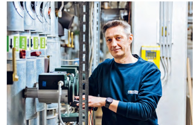
Im Einsatz überprüft MARC MENGER Ventile an einer Lüftungsanlage.
